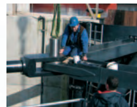
Системное решение для привода и устройства управления воротами поворотного сектора шлюза нового порта Бремерхафена – от планирования и конструкции до изготовления и монтажа.
