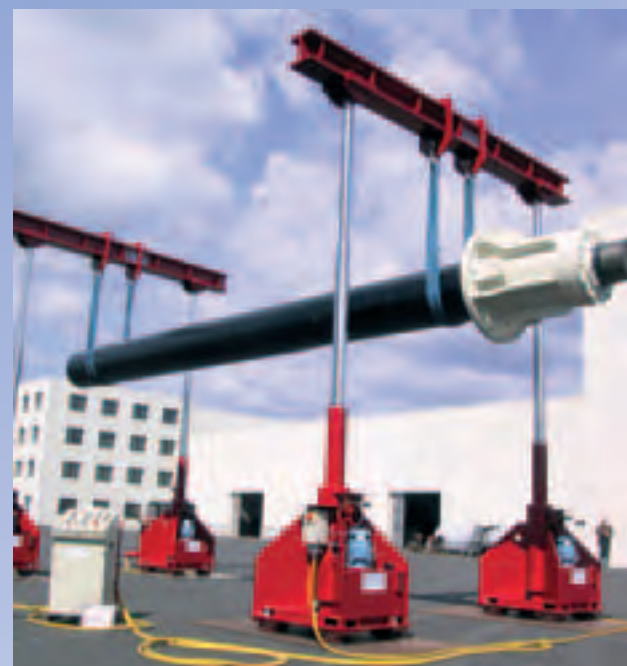
Гидравлическая подъемная система мощностью 1000 тонн
