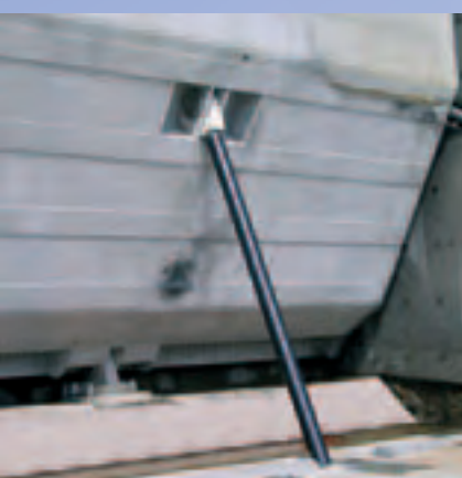
Цилиндр для управления задвижкой дамбы на реке в Колорадо.
